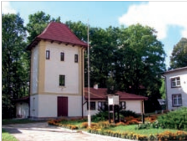
Fotografia 15. Dawna stacja transformatorowo-przemysłowa EW Żur (fot. J. Malinowski/Bractwo Czarnej Wdy)
