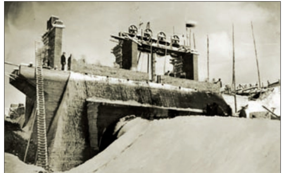
Fotografia 14. Archiwalna fotografia przedstawiająca budowę zamka wodnego EW Żur (Archiwum Państwowe w Bydgoszczy, grudzień 1929)
