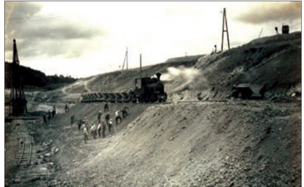
Fotografia 13. Archiwalna fotografia przedstawiająca budowę zbiornika Żur (Archiwum Państwowe w Bydgoszczy, grudzień 1929)
