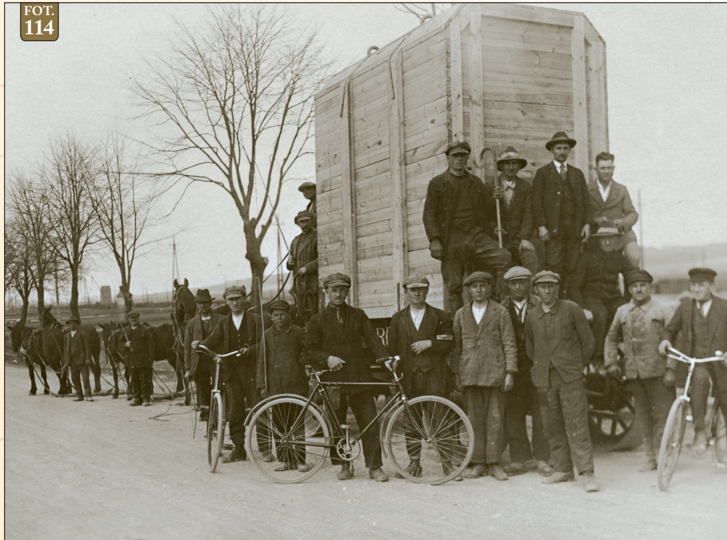
Fot. 114 –Transport transformatora 2000 kVA do podstacji „Gródka” 60 kV/15 kV w Gdyni. Zdjęcie wykonano 2 maja 1928 r.
