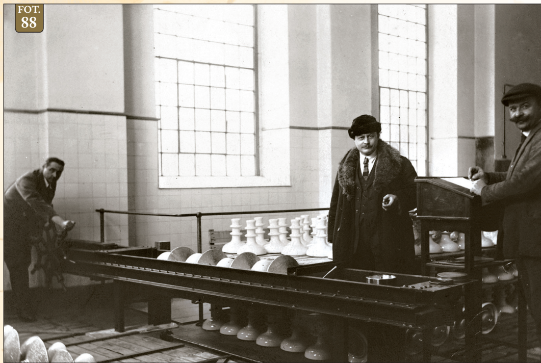
Fot. 88 – Próbné naciąganie czterech ogniów izolatorów typu Hf-35 siłą 4 kg za pomocą dynamometru 20-tonowego pod nadzorem inż. Alfonsa Hoffmanna
