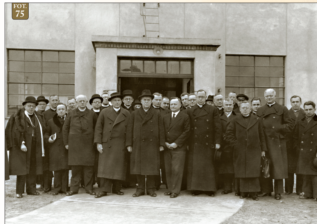
Fot. 75 – Uczestnicy kursu z inż. A. Hoffmannem przed budynkiem Fabryki Grzejników w Gródku
