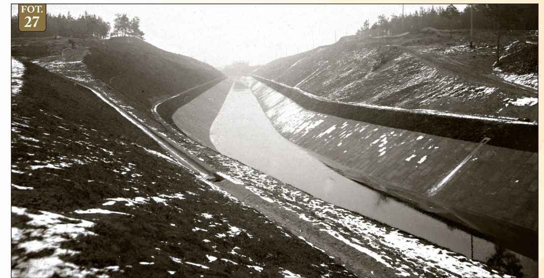
Fot. 27 – Kanał elektrowni z okładzinami z płyt betonowych w 1922 r.
