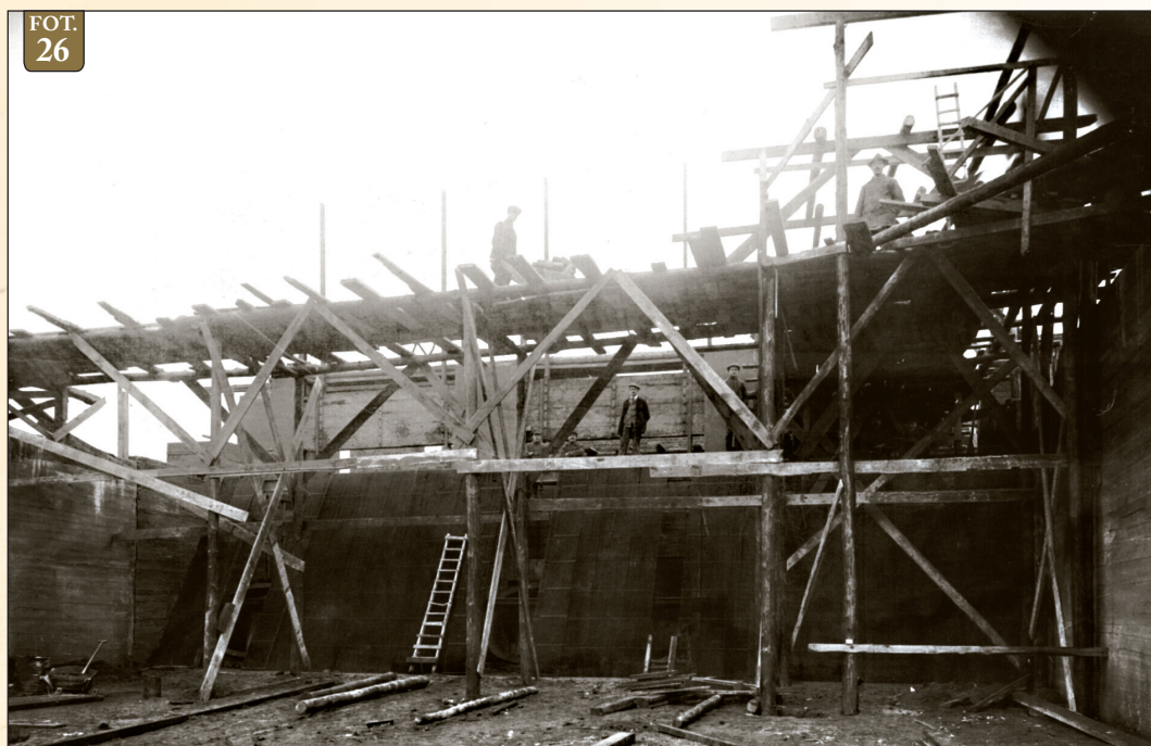
Fot. 26 – Betonowanie ścian oporowych nad wlotami do turbin powyżej dna kanału Elektrowni Gródek w dniu 23 listopada 1922 r.
