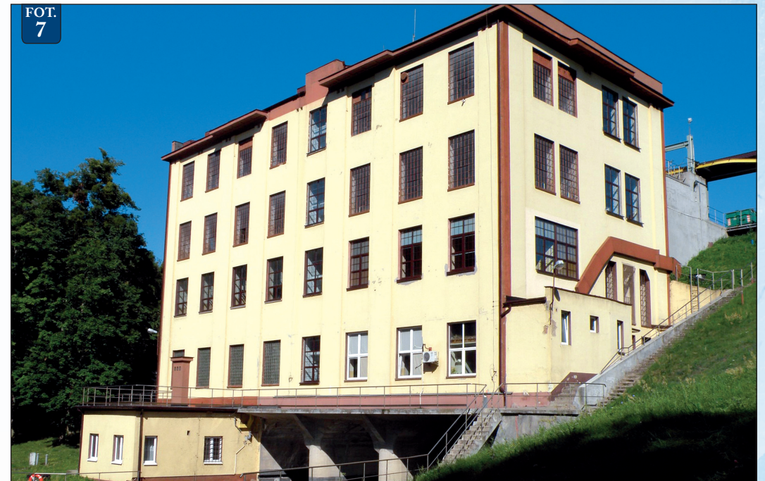
Fot. 7 – Budynek halli maszyn Elektrowni Wodnej Gródek od dolnej wody
