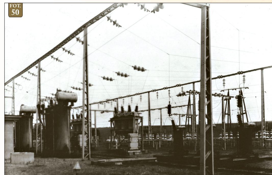
Fot. 50 – Fragment rozdzielni napowietrznej 60 kV w Żurze w 1930 r.
