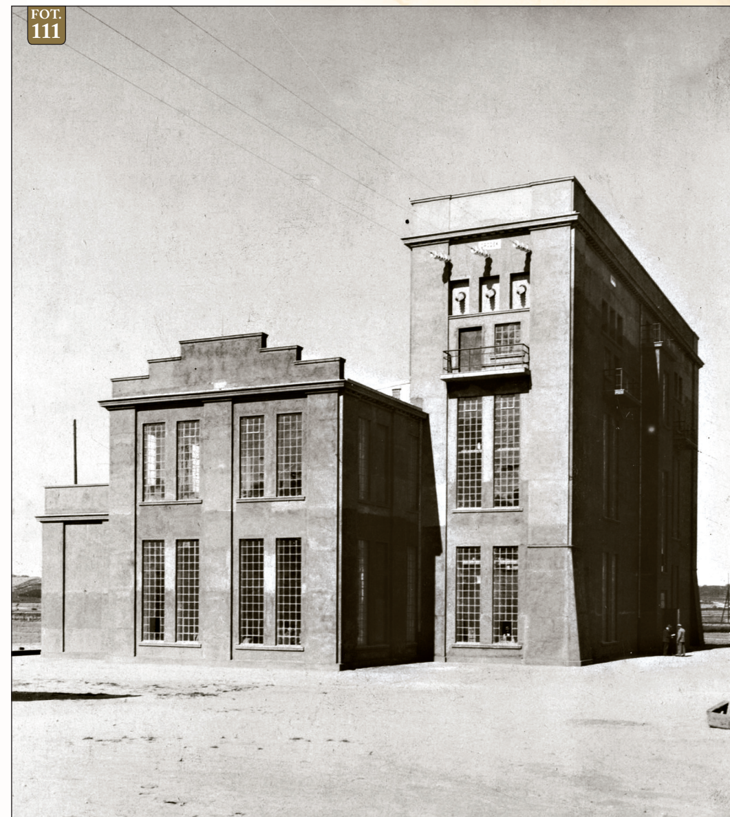
Fot. 111 – Stacja transformatorowa i rozdzielcza 60 kV i 15 kV PEK „Gródek” SA w Gdyni. Zdjęcie wykonano 7 września 1928 r.
