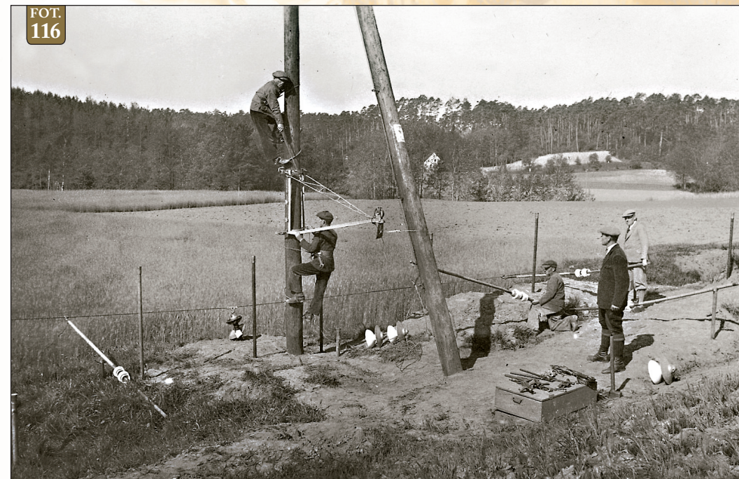
Fot. 116 – Naprawa linii 60 kV w Żurze pod napięciem. Zdjęcie wykonano 10 czerwca 1933 r.
