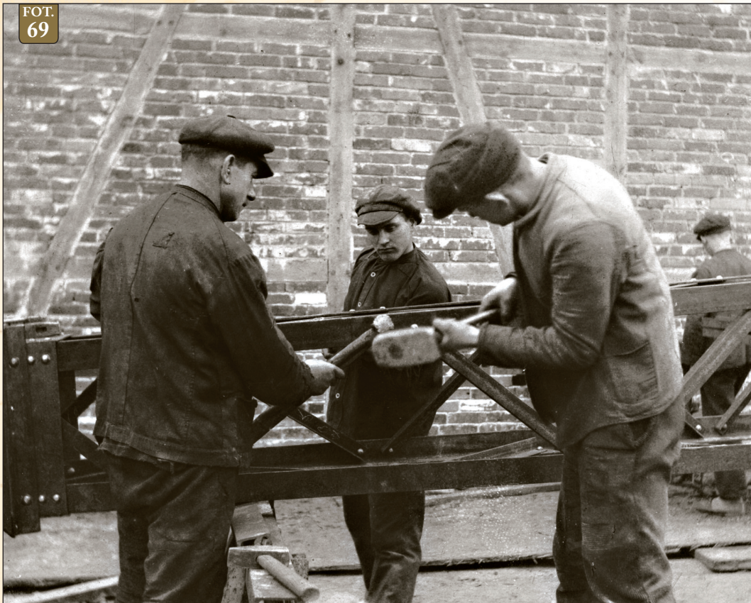
Fot. 69 – Nitowanie stupa kratowego dla linii 60 kV Gródek – Grudziądz. Zdjęcie wykonane latem 1928 r.
