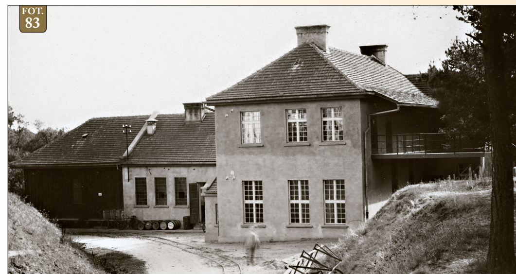
Fot. 83 – Fragment kompleksu budynków w Gródku, w których mieściły się laboratoria: olejowe oraz wysokich napięć. Zdjęcie z początku lat 30. XX w.
