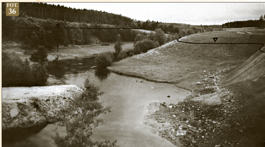
Fot. 36 – Widok doliny Wdy w lipcu 1929 r. na odcinku od miejsca planowanej zapory do okolic Grzybka. Linia pozioma widoczna na zdjęciu określa przewidywany poziom piętrzenia Zbiornika Żurskiego na tym jego odcinku
