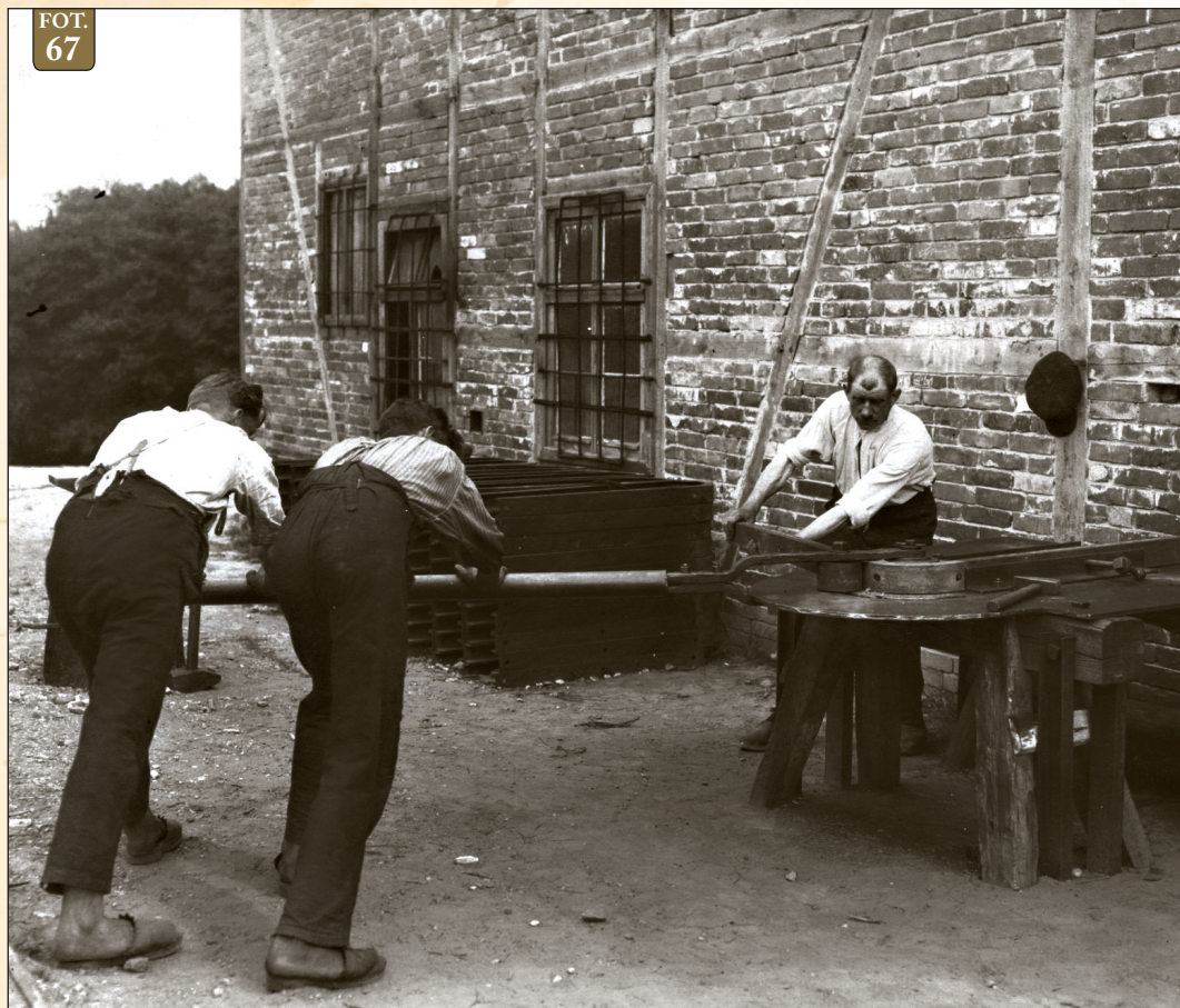
Fot. 67 – Prace przy tworzeniu konstrukcji słupowej. Widoczne specjalistyczne przyrządy i narzędzia służące do tego celu. Data wykonania zdjęcia – 20 lipca 1926 r.
